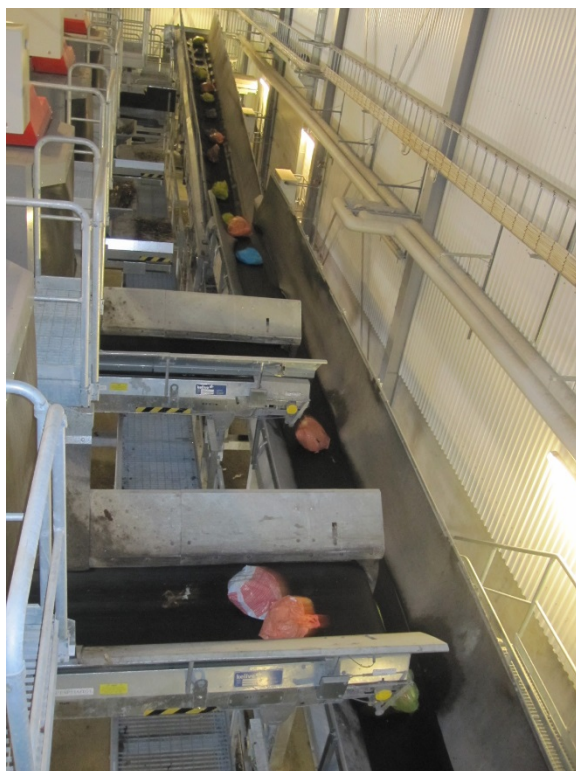
Figur 1 Optisk sortering i Eskilstuna. Här sker sortering i sju olika fraktioner.
